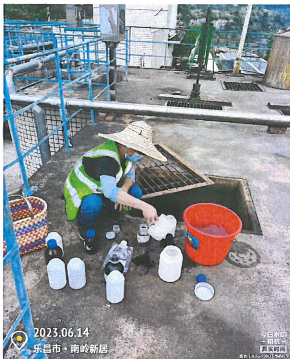
污水厂进水口
